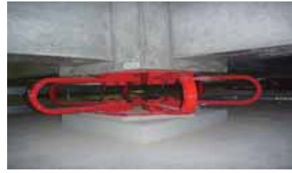
▲地震震動を減衰させる装置
