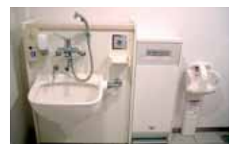
▲1階 多目的トイレ
