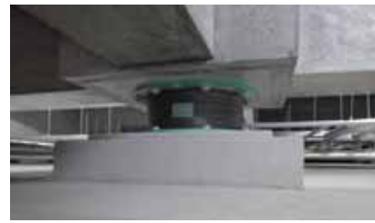
▲建物の支持と変形を復元する装置
