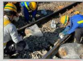
⑦ 線路の高さを調整する作業
