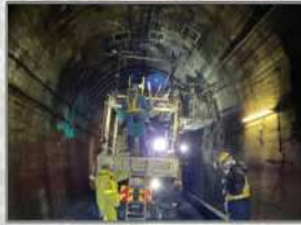
⑤ トンネル内の壁面修繕
