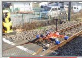
④ EVカートによる ※④ 落石検知装置の確認
