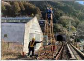
① タワーを用いた架線の点検
