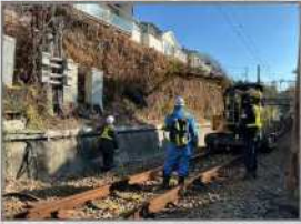
⑧ 機械を活用した除草・伐採作業
