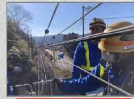
⑥ 高所作業車を用いた架線の点検
