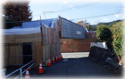
正門前の歩道橋は工事中です
