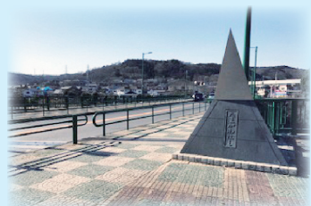
現在の多摩川橋
