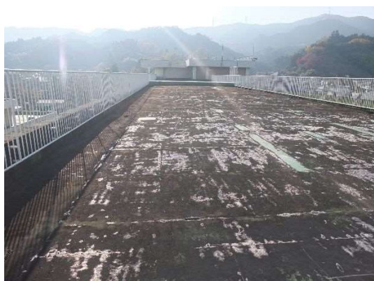
屋上防水の劣化状況
