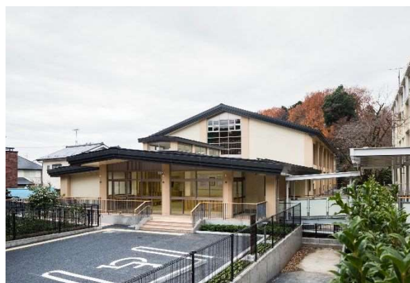
改築した第四小学校屋内運動場
