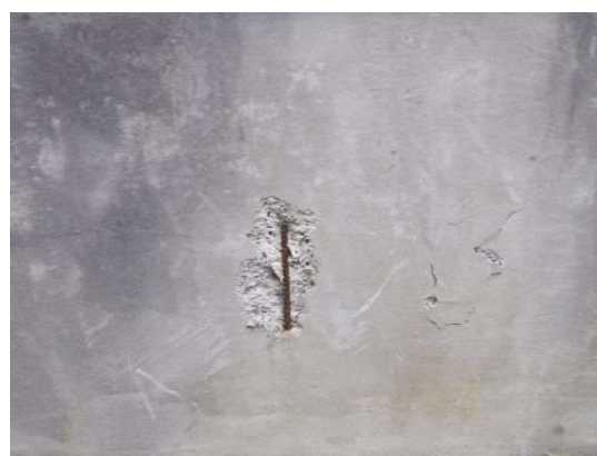
外壁鉄筋の腐食状況
