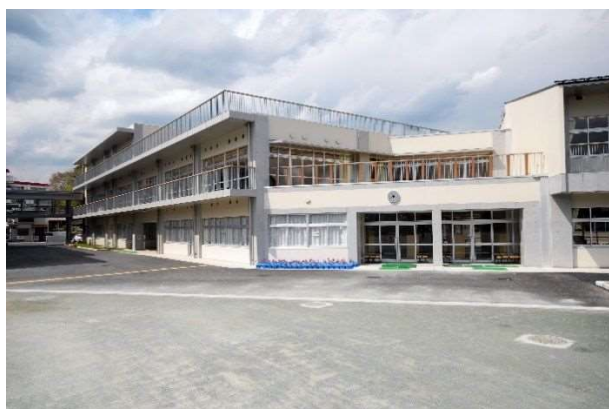
改築した第二小学校
