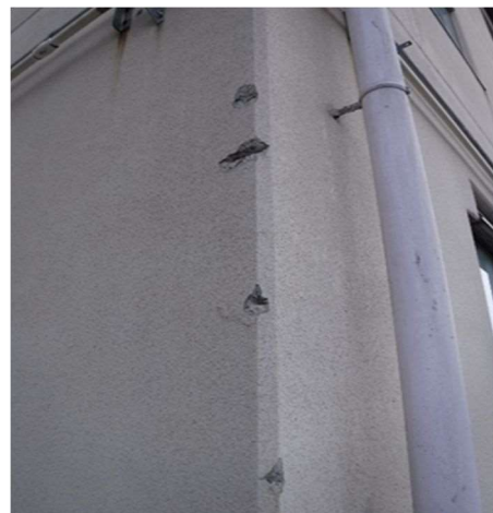
外壁鉄筋の腐食状況
