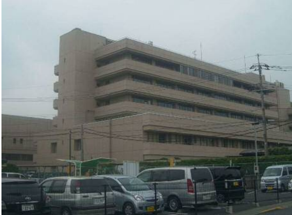
総合病院（東棟）
