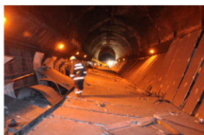
2012.12.2中央自動車道 笹子トンネル天井版崩落
