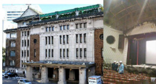
2011.3.11東日本大震災 九段会館(東京)天井崩落
