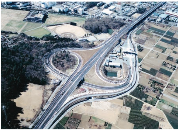
平成14年3月、圏央道の一部が開通しました。延長されたのは、青梅ICから日の出ICまでの8.7kmの区間で、市外へのアクセスが向上しました。
