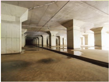
H19 霞川調節池
