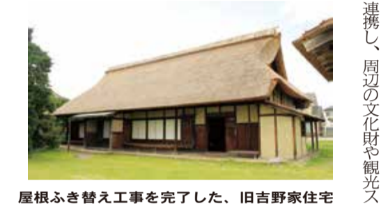
屋根ふき替え工事を完了した、旧吉野家住宅
