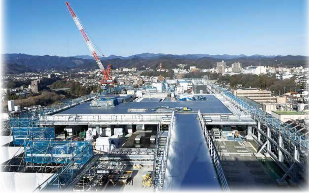
屋上部分では、ヘリポートの工事を行っています。また、建物内部では、空調設備や内装の工事などが進められています。総合病院建替特別委員会では、12月定例議会で今年度3回目の現地調査を実施しました。
