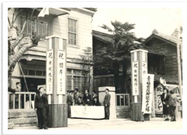
昭和 26 年青梅市役所旧々庁舎
