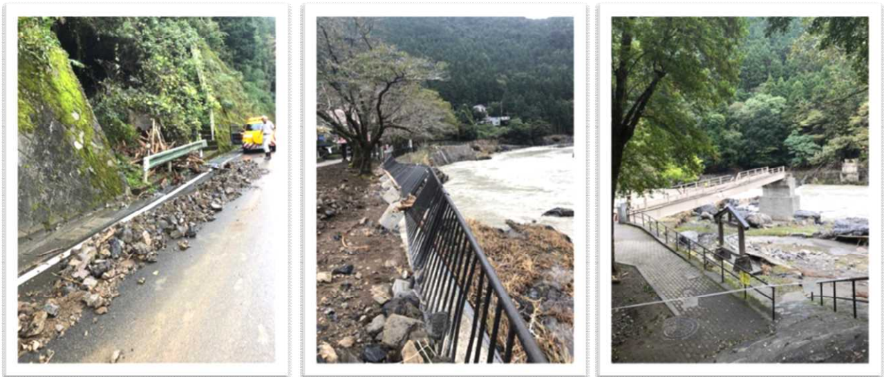
令和元年東日本台風(台風第19号)による被害③
