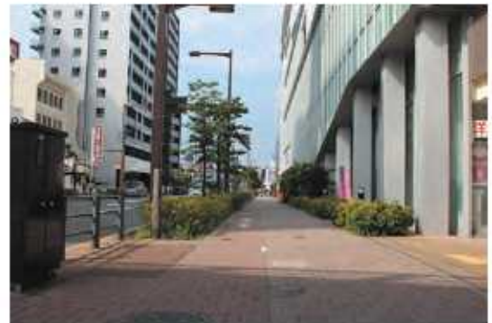
電線類の地中化
