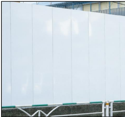
成形板による仮囲い(工事現場周囲に設置)
