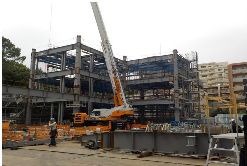
鉄骨組立工事
