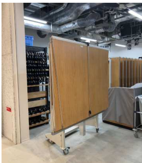
残響時間を調節する移動式反射板
