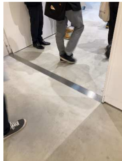
搬入口（左：トラック用の機材搬入口、右：楽器等の移動に支障が無いように段差を解消
