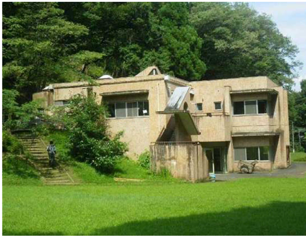
管理棟（改修前）
