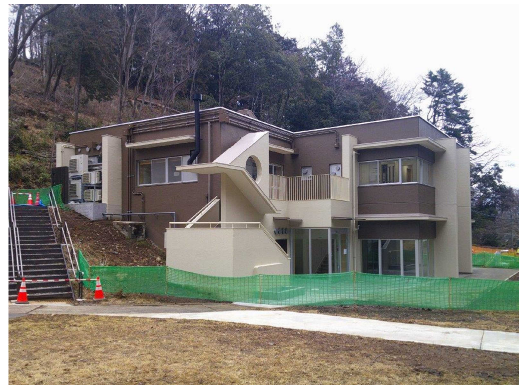
管理棟（改修後）
