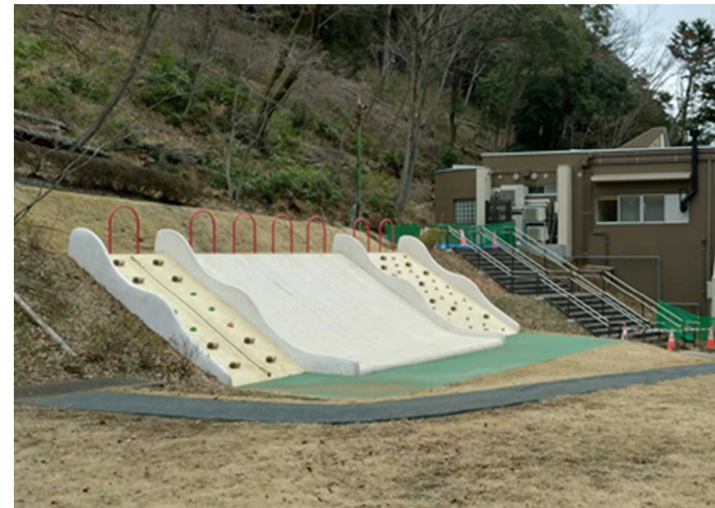
すべり台（設置後）
