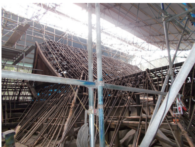
葺き替え工事の様子
