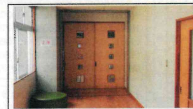
各棟の入口をしっかりと施錠します
