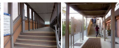
連絡通路内部
