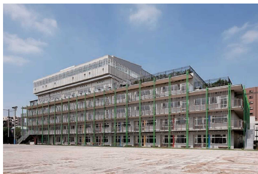
グラウンド側から見た校舎外観
