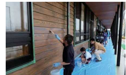
校舎完成後も、塗装職人のサポートのもと外壁メンテナンスを行う
