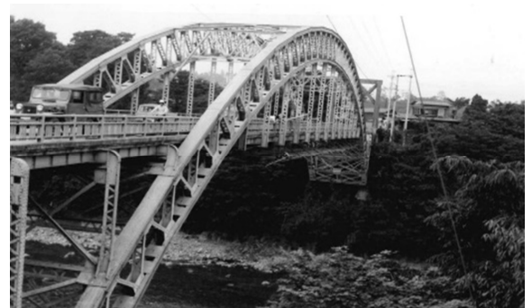
二代 調布橋 1935（昭和 10）年 岩浪建設（株）提供
