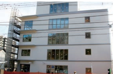
建設中の青梅市文化交流センター
