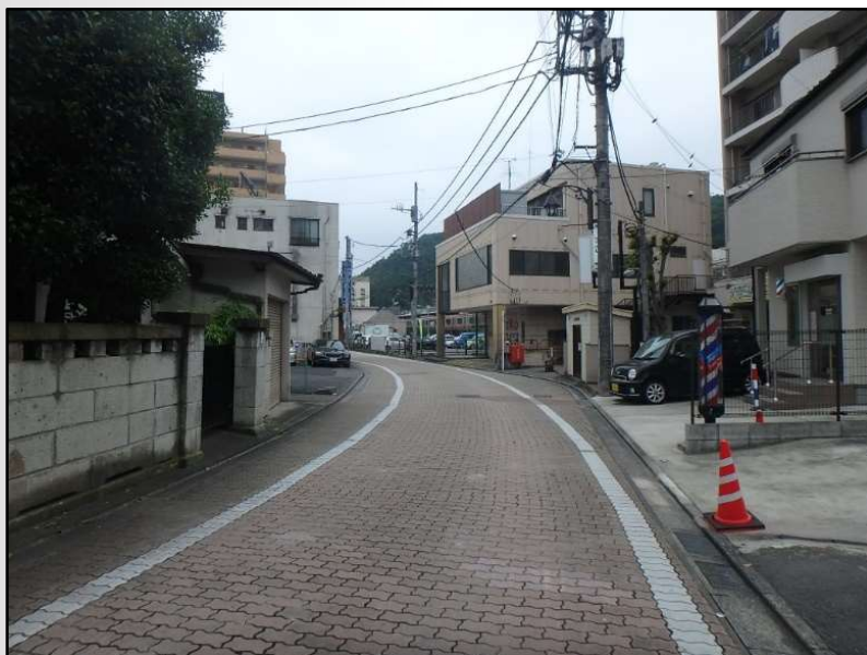
市道青2001号線 整備前（現況）
